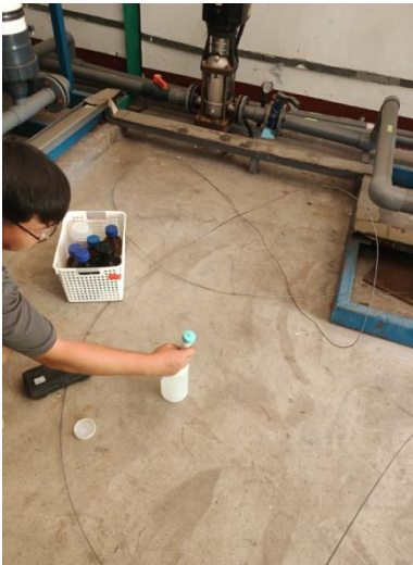
污水处理站出口
