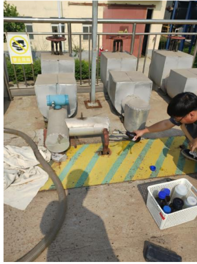
污水处理站进口
